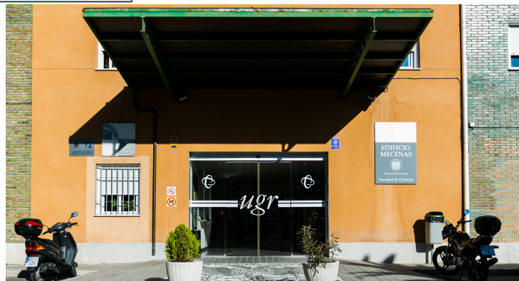
CSIRC - Fachada Edificio Mecenas
